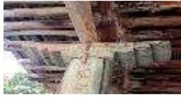
در قرار دادن تیرها بر روی ستون در فضاهای بزرگ به این مسئله توجه شده است، به این صورت که بر روی ستون، سر ستون، بر روی سر ستون تیر اصلی و بر روی آن تیرهای فرعی قرار می‌گیرد.
