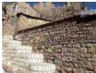
شکل ۷. ساخت رخیام با استفاده سنگ تخته‌ای در خانه‌های بومی پاره
