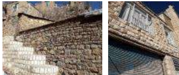
شکل ۷. ساخت رخاب با استفاده سنگ تخته‌ای در خانه‌های بومی پاوه
