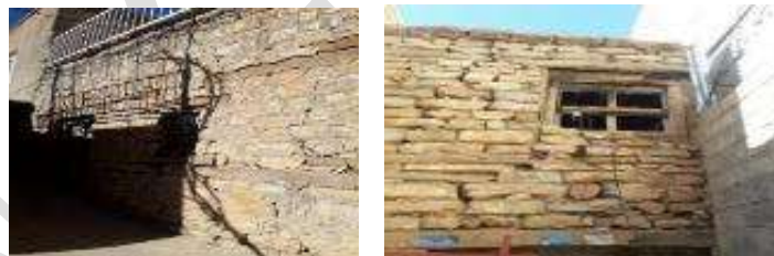
شکل ۸. ساخت رخاب با استفاده از تیرهای فرعی دیوار در خانه‌های بومی پاوه
