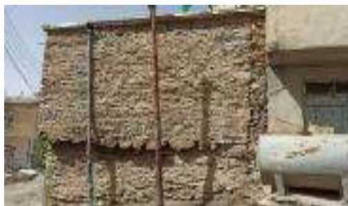
شکل ۹. ساخت رخیام در طبقات با استفاده از تیرهای فرعی در خانه‌های بومی پاه
