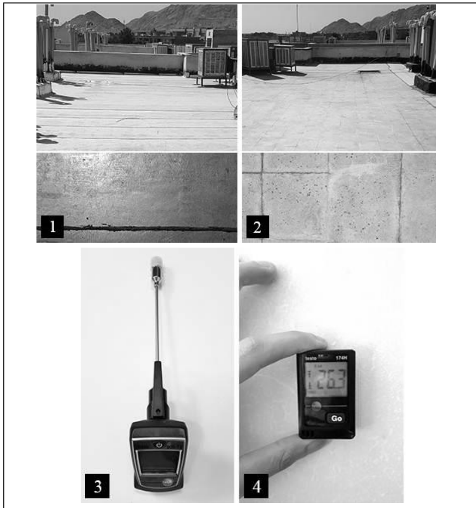
شکل ۲. ۱. بام A با پوشش ایزوگام؛ ۲. بام B با پوشش موزاییک؛ ۳. دیتالاگر سنجش دمای سطح؛ ۴. دیتالاگر سنجش دمای هوا
