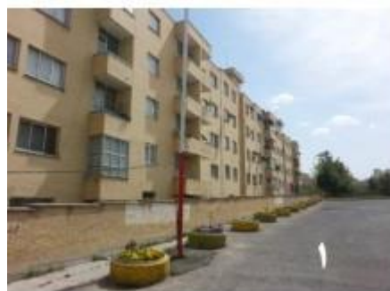
مجموعه مسکونی امیرکبیر
